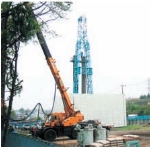
温泉掘削中の温浴施設予定地(花小金井南町三丁目)
